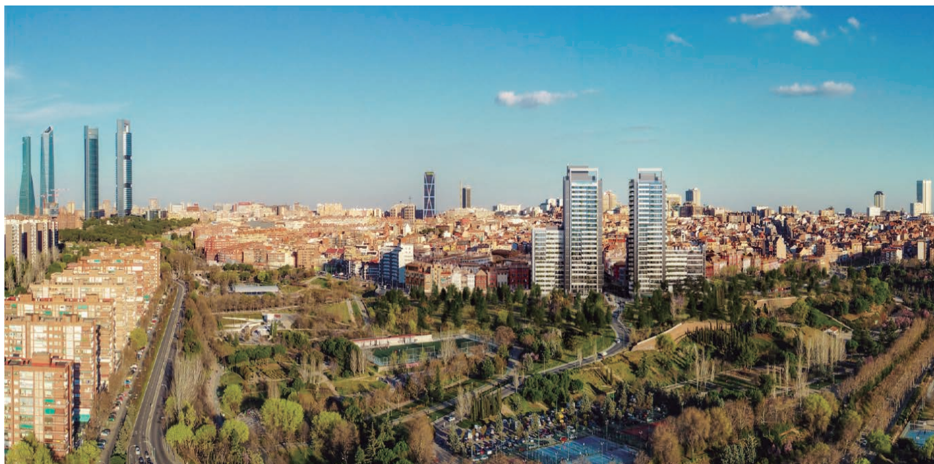
Skyline, Madrid, proyecto promovido por Stoneweg. M&G adquirió una de las torres actualmente en construcción que se comercializará en alquiler
