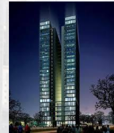
Lancaster Luminaire ~126 units
